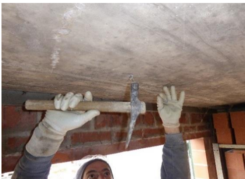
Versetzen der Schlagankerhülse in Betondecke
