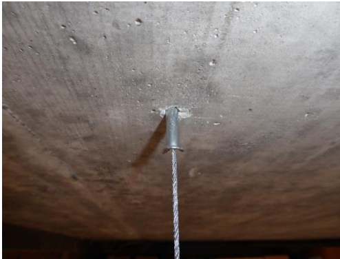
Schlagankerhülse in Bohrloch
