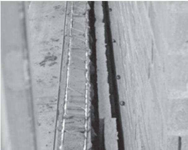
Vertikalschnitt der Lagerfuge mit Murinox® Lagerfugenbewehrung:
